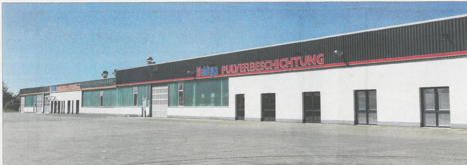
Die Firmengruppe Wehlage mit Sitz im emsländischen Lengerich hat rund 900.000 Euro in die Erweiterung ihrer Pulverbeschichtungsanlage investiert.
