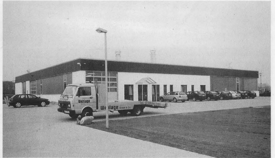
DIE NEUE HALLE, die am Sonntag beim „Tag der offenen Tür“ der Öffentlichkeit präsentiert wird, beherbergt eine hochmoderne Pulverbeschichtungsanlage und eine der fortschrittlichsten Fahrzeuglackierereien des Emslandes.
