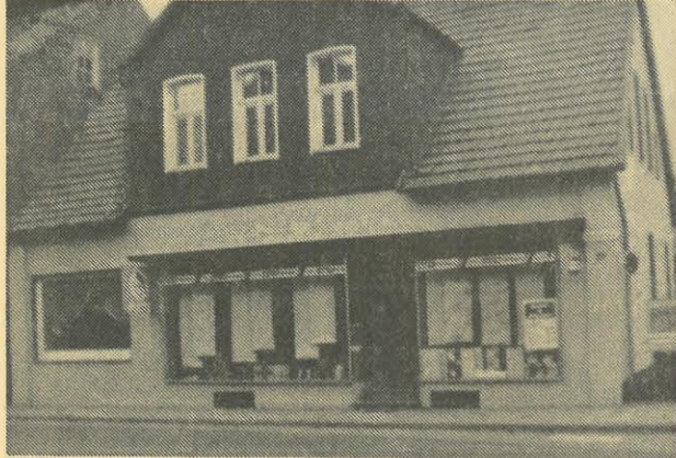
Das ehemalige Geschäftsgebäude an der Kirchstraße 29 in Lengerich.
